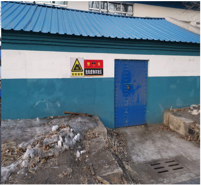
危险废物暂存间
